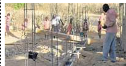
Die Fundamente werden bereits gesetzt. Foto: Pouilly
