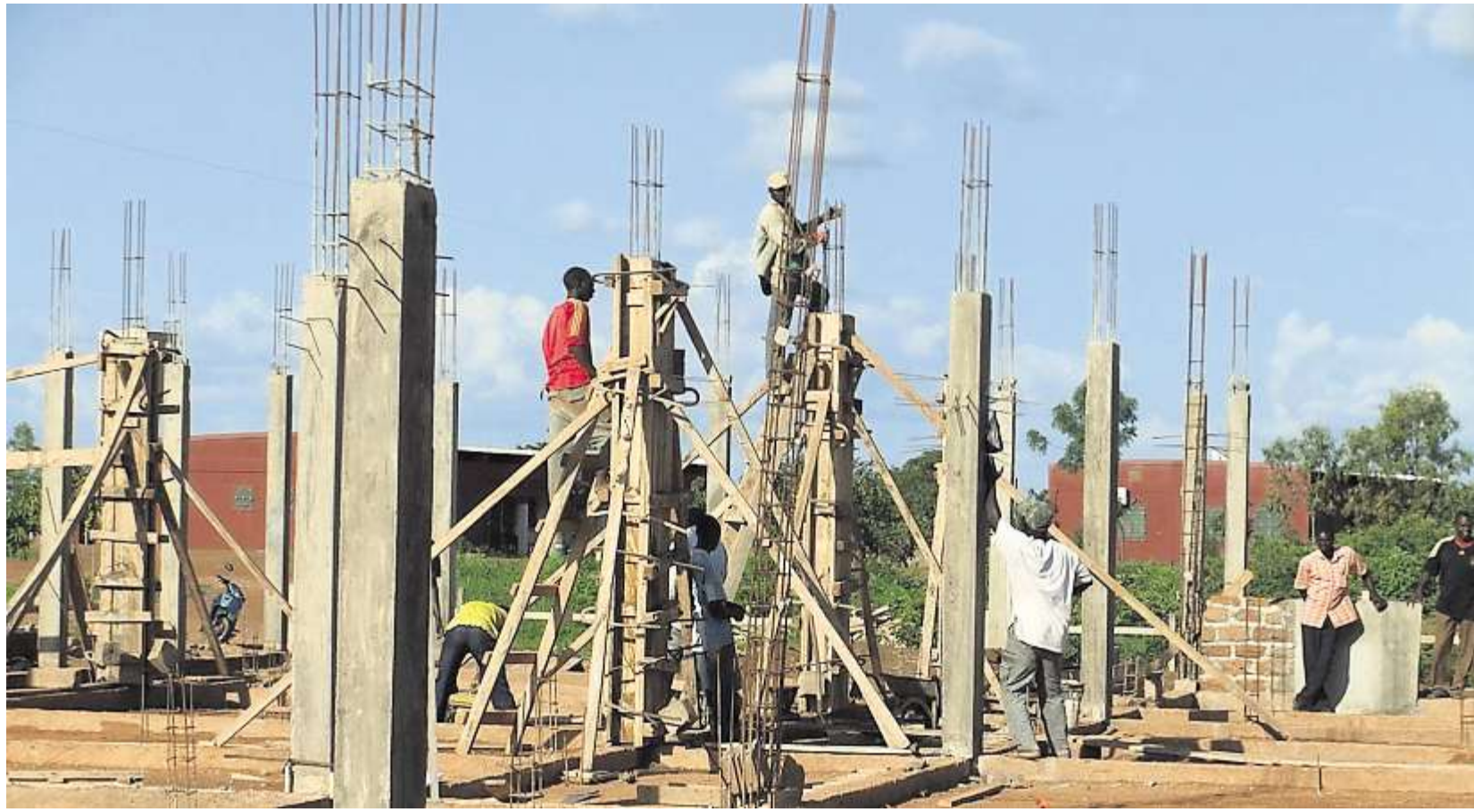
Gerüstbau auf afrikanisch: In brütender Hitze errichten die Bauarbeiter die Betonständer für die Geburtshilfestation. Im Hintergrund sind die verschiedenen Bauten des Gesundheitszentrums zu erkennen. Fotos: Kirchmann, Forster
