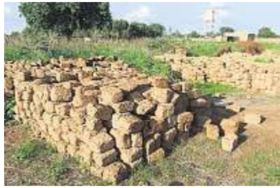
Mit Lateritsteinen werden die einzelnen Wandelemente zwischen den Betonständern gefüllt.
