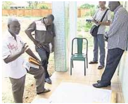
Baustellenbesprechung unter dem schattenspendenden Vordach.
