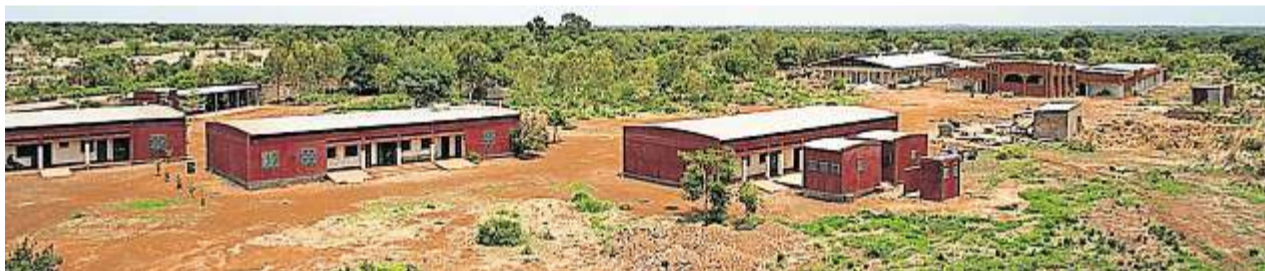
Das Medizinische Zentrum Maximilien Kolbe in der Savanne bei Sabou: die drei Gebäude von links sind Apotheke, Sprechzimmer und Bettentrakt, rechts hinten ist der CREN, das Ernährungszentrum zu sehen, links daneben der Neubau.
