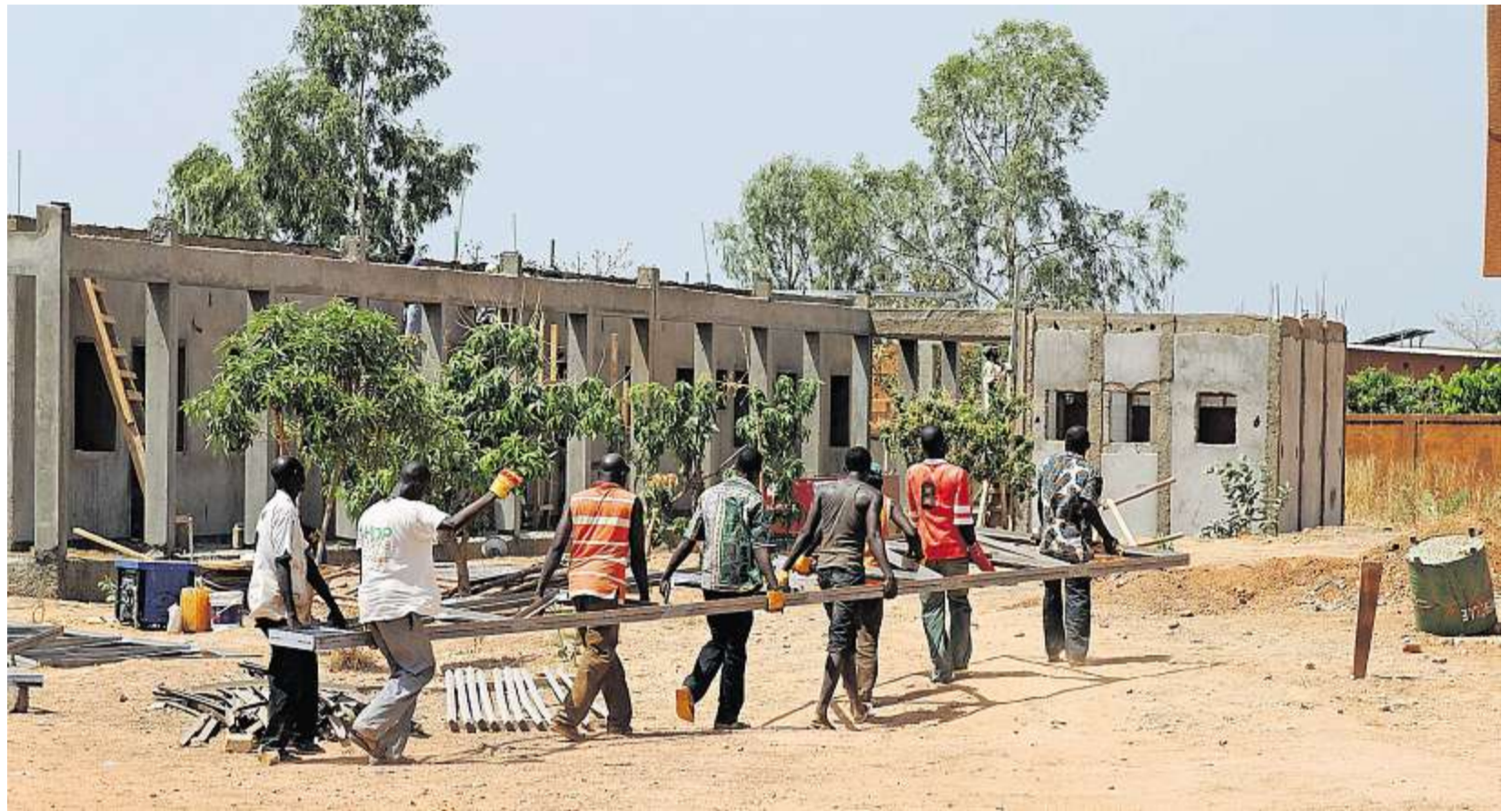
Nur mit Muskelkraft, ganz ohne Kran, hieven Arbeiter den Dachstuhl auf den Rohbau. Die Träger bestehen aus Stahl, denn Holz fällt in dieser Region als Baumaterial komplett weg – die Termiten würden es befallen.
