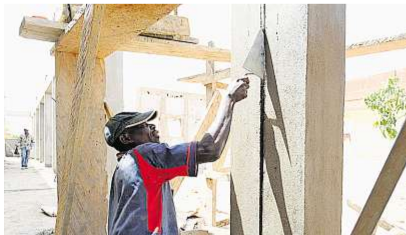
Die Arbeiten sind weit fortgeschritten – hier wird die Dehnungsfuge des langen Hauptgebäudes verputzt.
