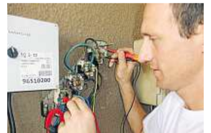
„Zauberer“ Rudolf Renner setzte die Energieversorgung im Gesundheitszentrum wieder in Gang.
